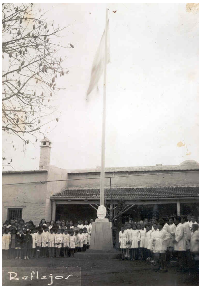
Patio de la escuela 252, mástil inaugurado el 25 de mayo de 1946. Tercer local, calle 8 esquina 25
