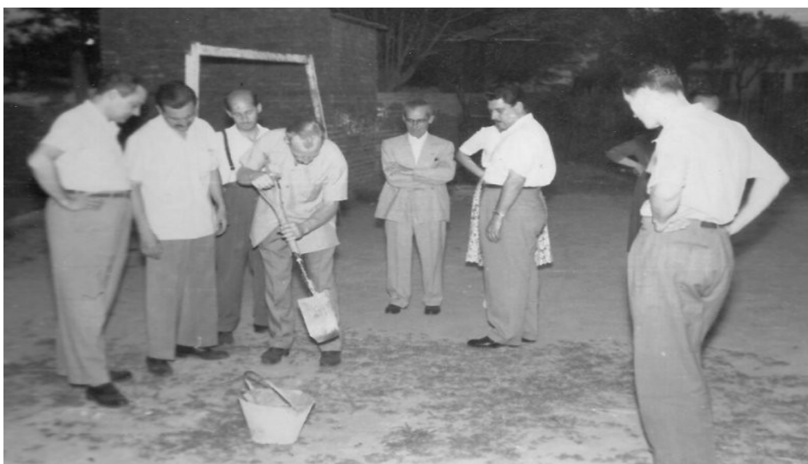
Acto de colocación de la Piedra Fundamental del edificio del Teatro del Pueblo.
