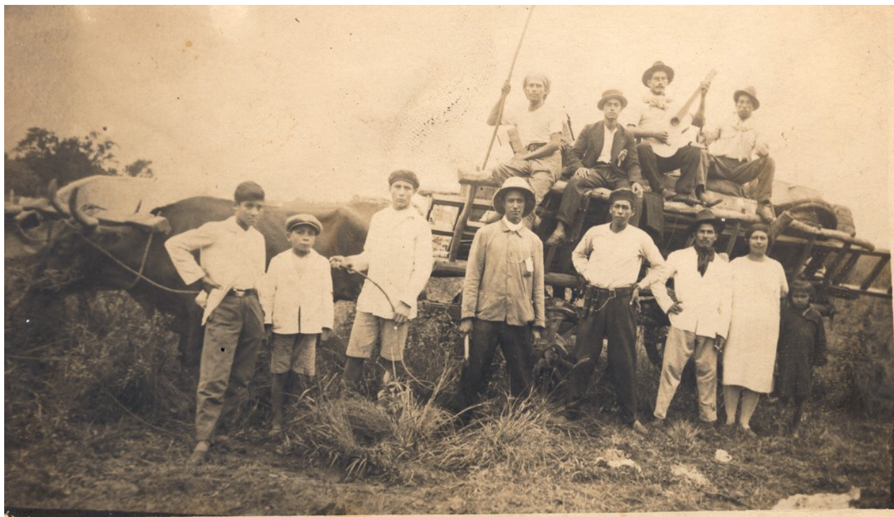
Trabajadores de la Compañía Internacional de Teléfonos. El de casco es Acosta, el capataz. Se aprecian las escaleras y postes de palmera cargados en el cachapé.
